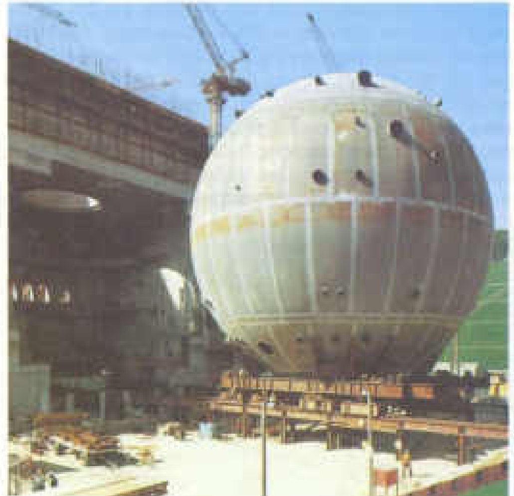
Abb. 7.3.7 Der fertige Sicherheitsbehälter eines Siedewassersreaktors wird in das Reaktorgebäude gefahren
