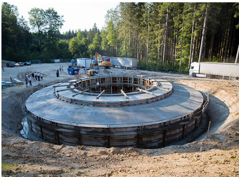
Fundament einer 3-MW-WEA
